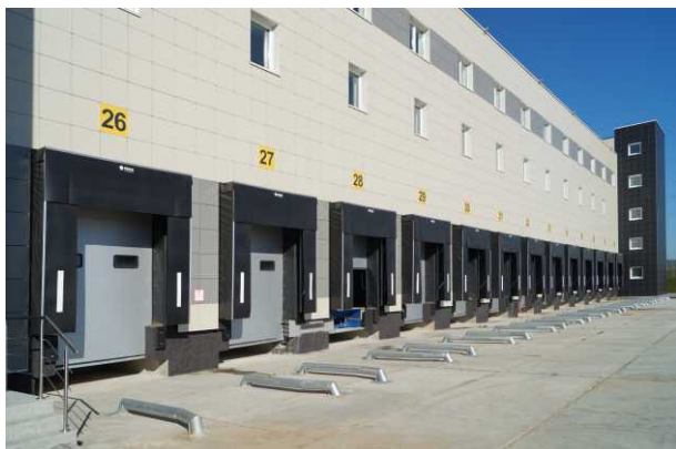
БЛТ-Логистик, ИП, пос.Обчак - механический складной герметизатор ворот PMV - направляющие для колес - секционные ворота - гидравлическая перегрузочная платформа РТ
